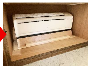
メーカーさんのアドバイス通り吹き出し口だけを囲ってパッキンで気密！
