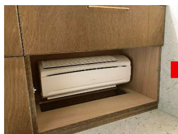
こんな感じで洗面台の引き出しの下に穴を開けてエアコンを取付
