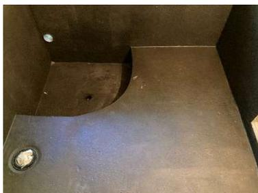
モルタル下地が終わったら次は防水工事です。壁や床に水が浸入しないようにきっちり防水施工します。写真の黒くなった部分が防水仕上げです。この後もう一度モルタルで下地を作ります。特に床は排水金具に向かって水が流れるように勾配をしっかりとっていきます。このタイミングで大工さんに入ってもらい、天井と壁を仕上げてもらいます。天井は杉板、壁にはヒノキの羽目板を貼ります。ヒノキは水に強いのはもちろんですが、何といてもその香りです。主成分となる
