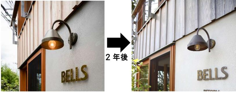
写真は事務所前の外壁の様子です。1階がモルタル仕上げで2階が杉板を貼っています。それも無塗装で。左は新築直後でほんのりと杉板の赤身が分かりますが、2年経って赤身も無くなりうっすらとシルバークレーに変色していますね。これは木材に含まれている変色物質が水に溶けやすく、雨
