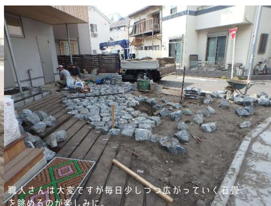
気の遠くなる作業ですが、石のくせを確認しながら一つ一つ丁寧に据えていきます。
