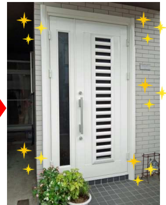
ドアを取付完成～
