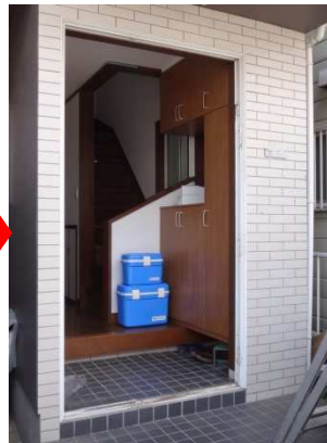
ドアや格子を撤去して 枠だけが残った状態
