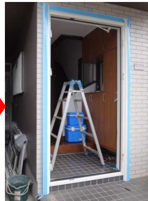
新しい枠をかぶせました
